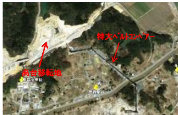
高台移転工事（上空から見た様子）
